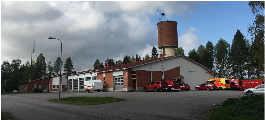
Haapajärven paloasema on poistumassa alueelta, ja rakennukselle etsitään uusi käyttötarkoitus.
