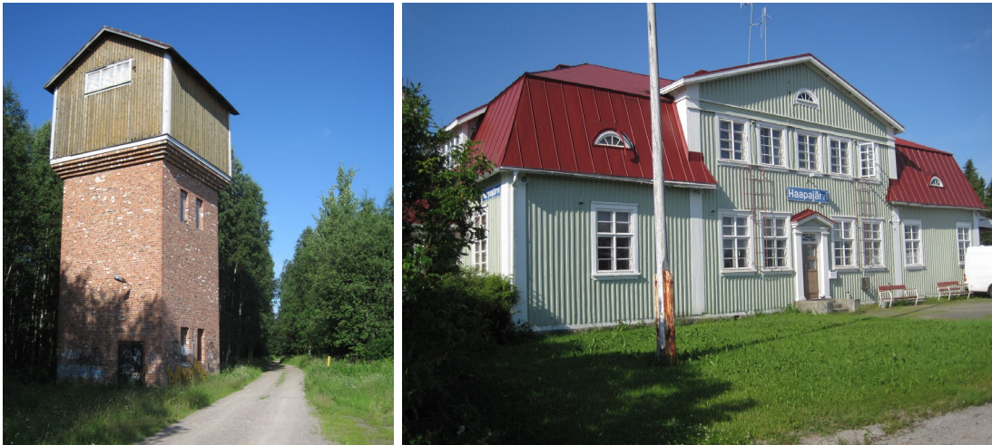
Haapajärven asema-alueen rakennuksia.
