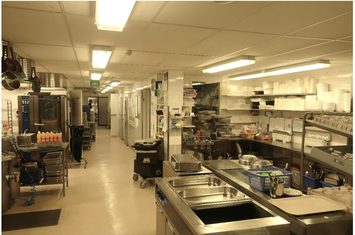
Kuva 68. Keittiössä on akryylihiertomassalattia ja seinillä keraaminen laatoitus vuosilta 2006–2007.
