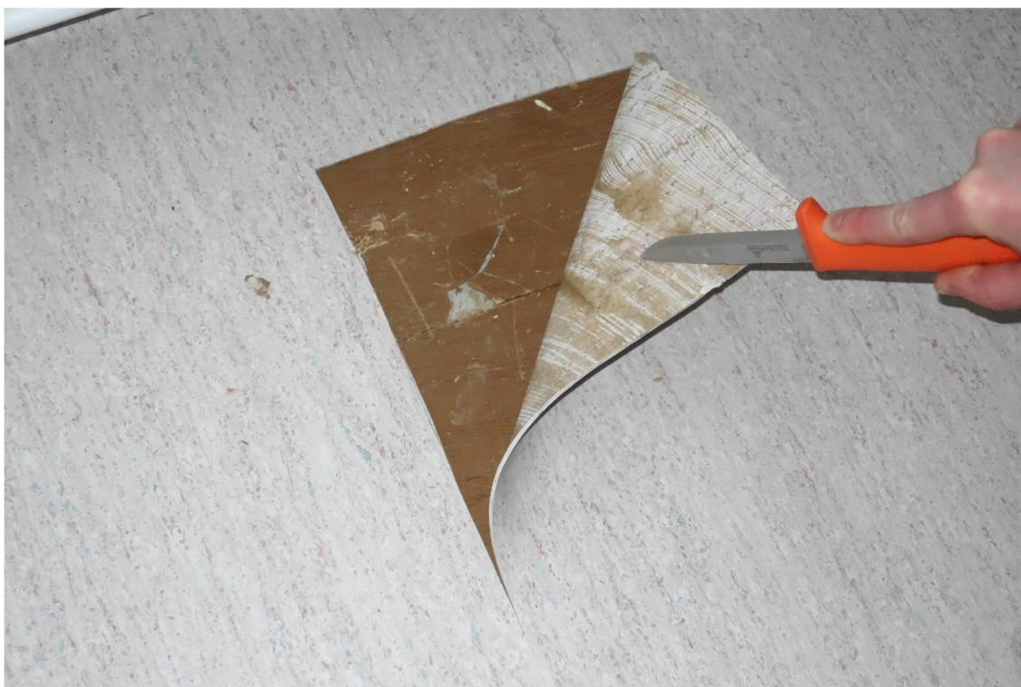
Kuva 32. Lähinnä osan 3 kuivissa tiloissa on lattianpäällysteenä olevan muovimaton alla vielä todennäköisesti alkuperäiset kvartsivinyylilaatat. Kuva on otettu tilasta 187.
