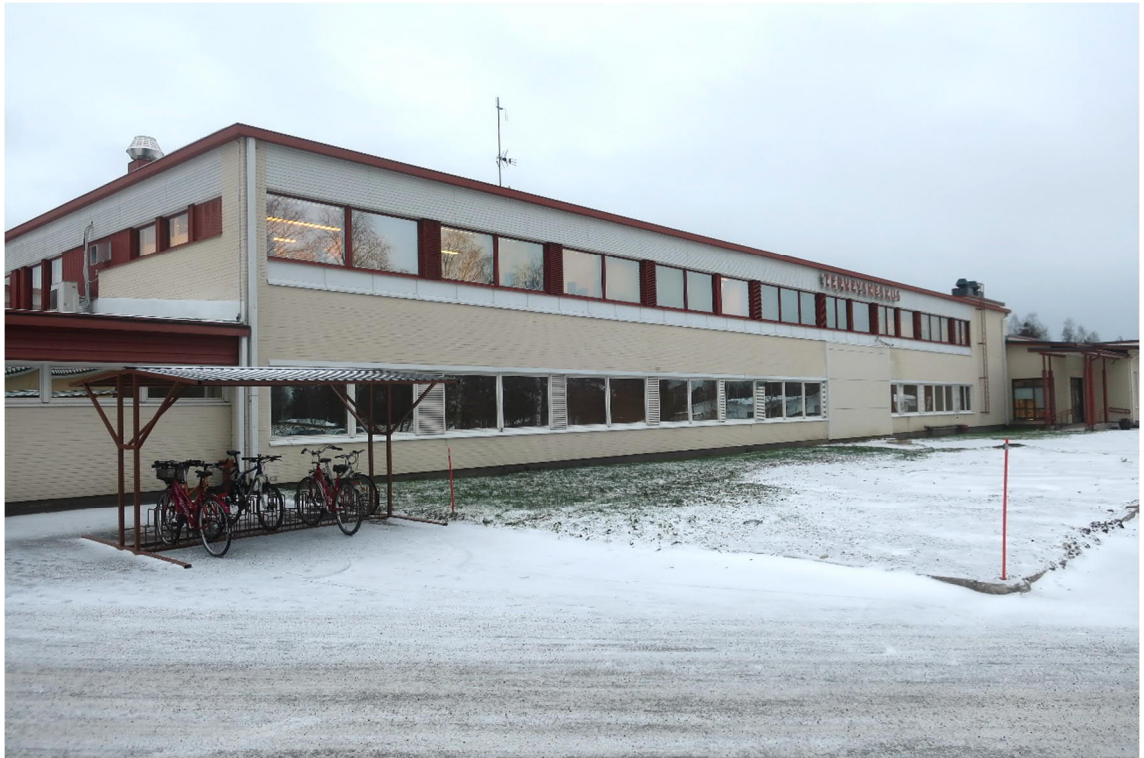
Kuva 1. Yleiskuva rakennuksen 2-kerroksisen osan 3 länsijulkisivulta.
