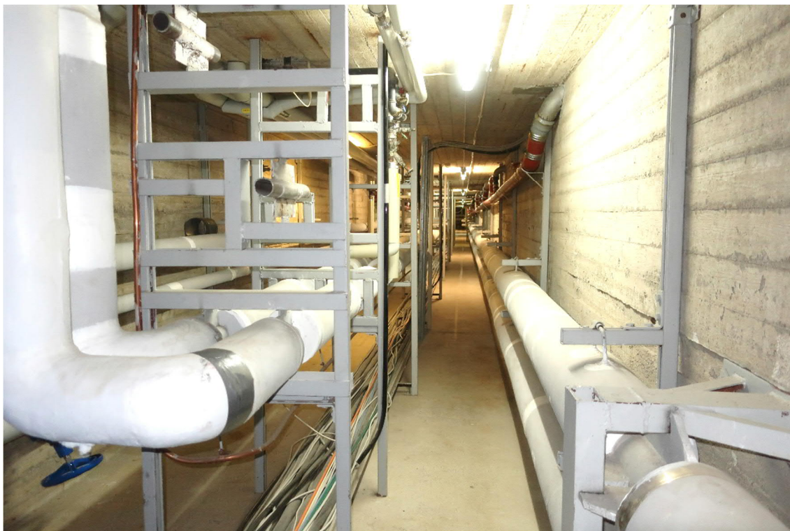
Kuva 22. Osien 1 ja 3 huoltotunneleiden alueella maanvastaiset seinät ovat lämmöneristämättömiä betonirakenteita. Näiden seinien mahdollisesta ulkopuolisesta veden-/kosteudeneristyksestä ei ole tietoa.
