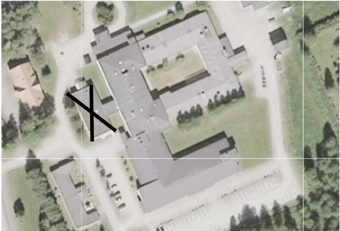
Kuva 59. Viistoilmakuva tutkimuksen kohteena olevasta rakennuksesta. Rakennuksen vesikat- tomuotona on loiva harja-/aumakatto, ja vesikatteina on eri-ikäisiä 2-kertaisia bitumikermikat- teita. Kesällä 2020 purettu osa 4 on merkitty mustalla rastilla.
