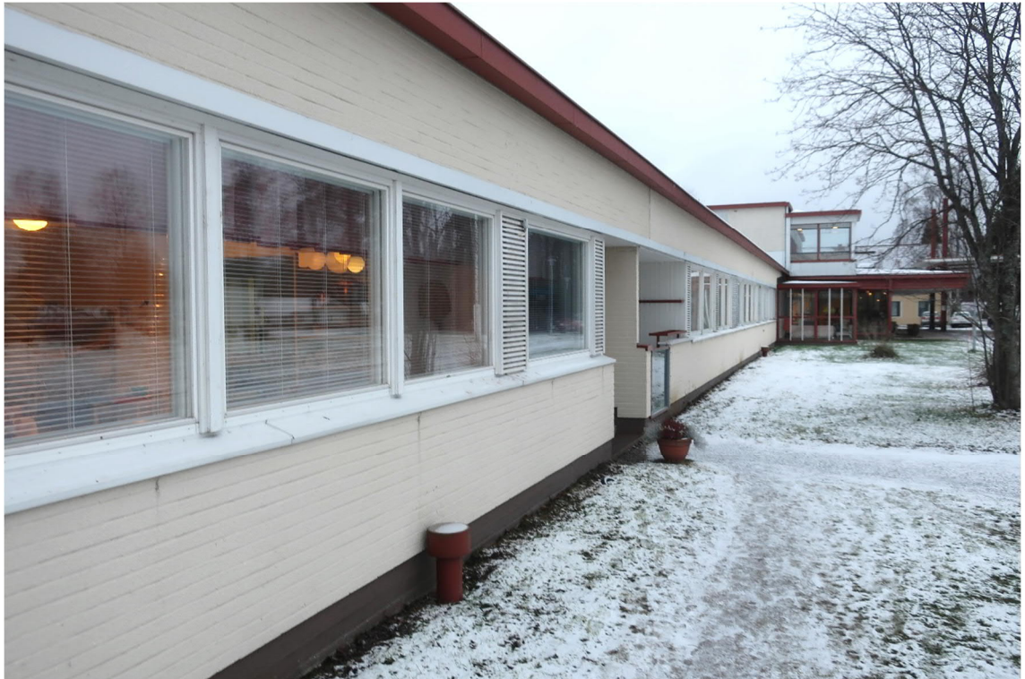
Kuva 12. Seinustoilla maanpinnan taso on havaintojen mukaan pääosin vaihtelevasti noin 0,1...0,3 m 1. kerroksen lattiapinnan tason alapuolella. Kuva on otettu osan 1 pohjoisjulkisivulta.
