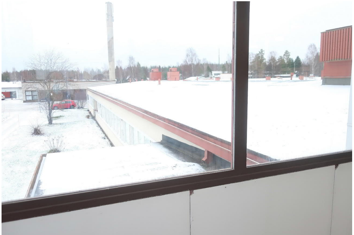
Kuva 51. Osan 3 porrashuoneessa on kiinteät, 2-lasiset teräsprofili-ikkunat.
