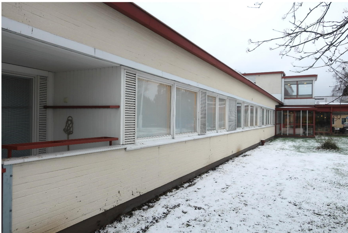
Kuva 3. Yleiskuva rakennuksen osan 1 pohjoisjulkisivulta.
