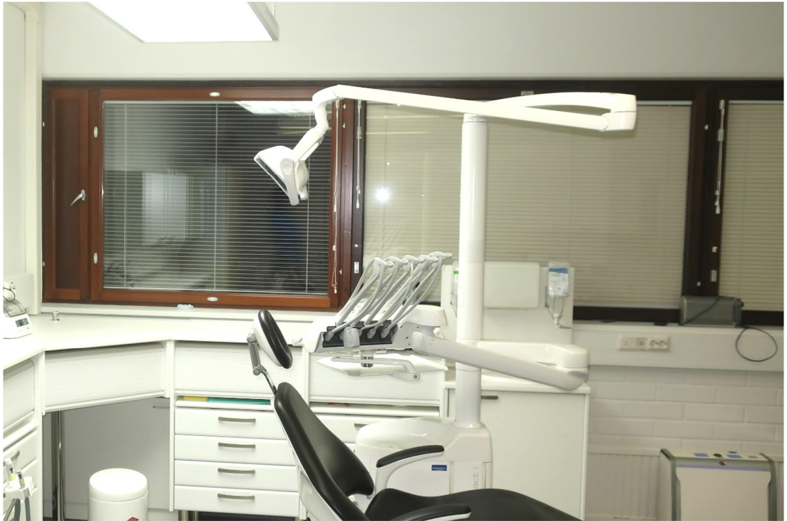
Kuva 50. Osan 3 2. kerroksessa ikkunat ovat pääosin alkuperäiset, vuodelta 1988. Osassa 2. kerroksen tiloista on kuitenkin jossakin vaiheessa korvattu yksittäiset ikkunat uusilla, tuuletusluukuilla varustetuilla ikkunoilla ikkunatuuletuksen mahdollistamiseksi.
