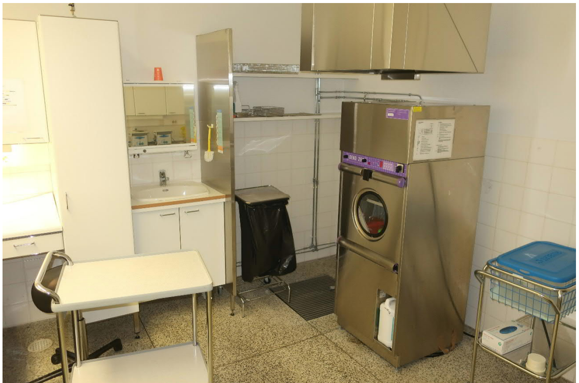
Kuva 69. Välinehuoltotiloissa (tilat 160 ja 161) on alkuperäinen mosaiikkibetonilattia ja seinäpinnoilla on keraamista laatoitusta.
