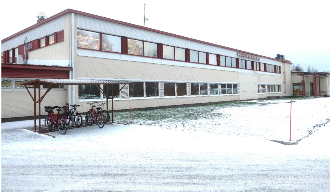
Kuva 42. Rakennuksen 1. kerroksen ulkoseinät ovat pääosin ei-kantavia, tiili-villa-tiilirakenteisia seiniä. Julkisivut ovat puhtaaksimuurattuja kalkkihiekkatiilipintoja, jotka on ilmeisesti viimeisimmän peruskorjauksen yhteydessä vuosina 2006–2007 pinnoitettu maalaamalla. Ulkoseinien alaosassa on matala valesokkelirakenne, jossa rakennuksen ulkopuolella näkyvä sokkelipinta ulottuu noin 5 cm 1. kerroksen lattiapinnan yläpuolelle. 1. kerroksen lattiapinta on kuitenkin pääosin noin 20...30 cm maanpinnan yläpuolella. Kuva on otettu osan 3 länsijulkisivulta.
