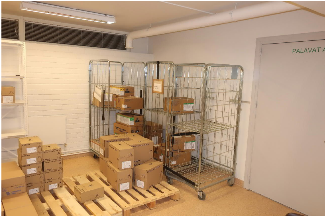
Kuva 21. Osien 1 ja 2 lämpimien kellaritilojen alueilla maanvastaisissa seinissä on rakennusajalle tyypilliseen tapaan verhomuuraus. Kuva on otettu tilasta 017E.
