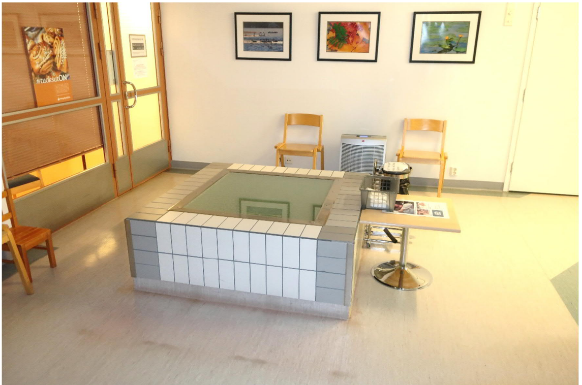
Kuva 35. Osan 3 välipohjassa on 3 kpl valokuiluja 1. ja 2. kerroksen välillä vanhan yläpohjan/vesikaton kattoikkunoiden kohdilla
