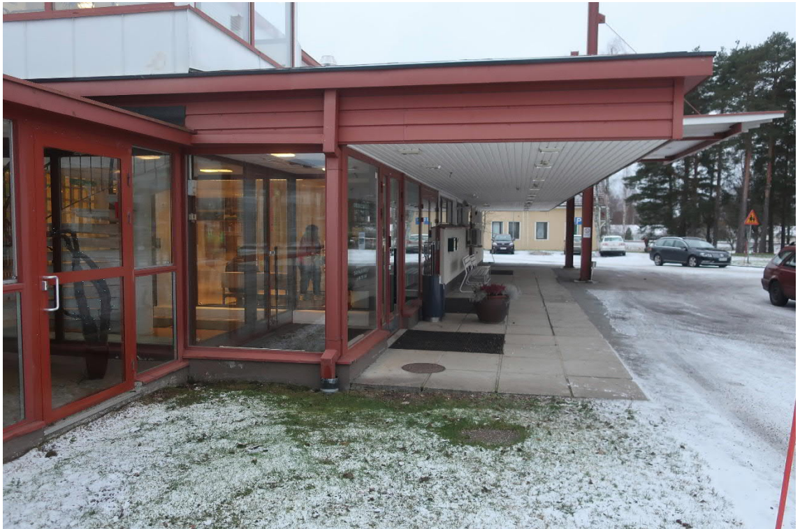
Kuva 52. Ulko-ovet ovat pääosin ikkunallisia teräs- ja alumiiniprofiiliovina.
