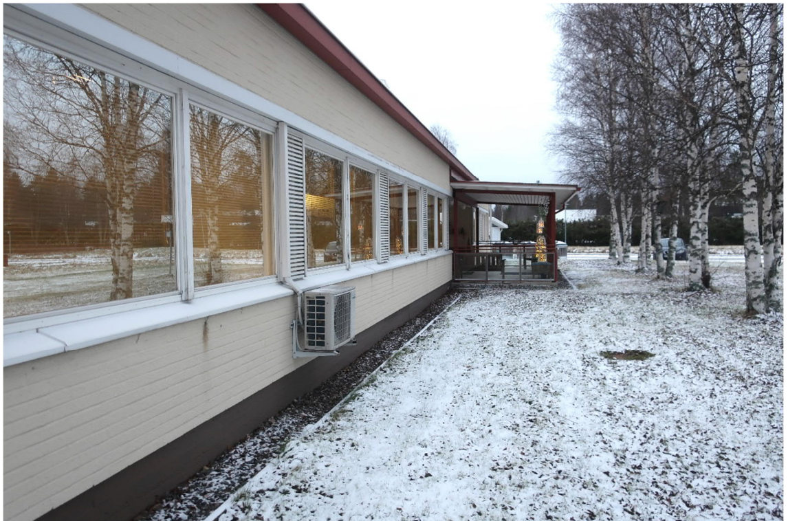
Kuva 11. Kellarillisilla alueilla nurmipinnat eivät ulotu sokkelipintaan asti, vaan rakennuksen seinustoilla on noin 0,5 m leveä sepelipintainen kaistale. Kuva on otettu osan 2 eteläjulkisivulta.
