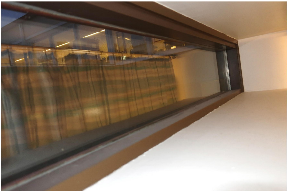
Kuva 49. Osa ikkunoista on kiinteitä, 3-lasisia puuikkunoita
