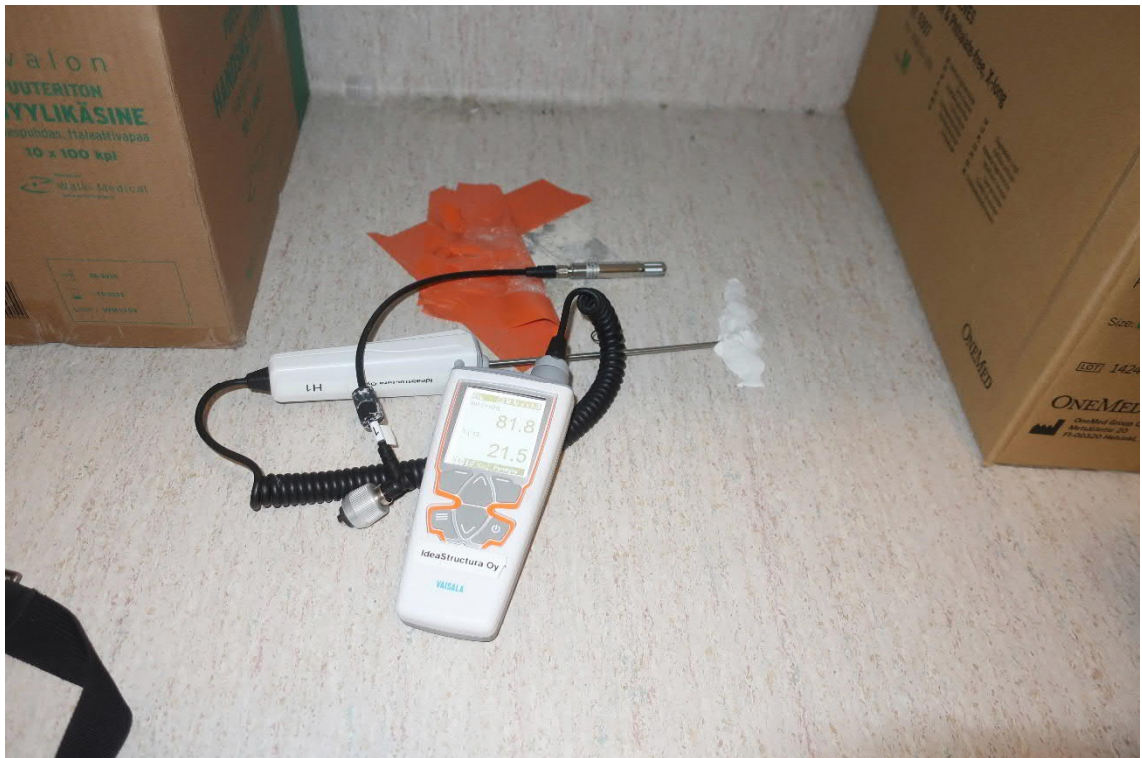
Kuva 31. Viiltokosteusmittaus pisteessä K6 liinavaatevarastossa 213. Suhteellinen kosteus muovimaton alla oli 82 % RH.
