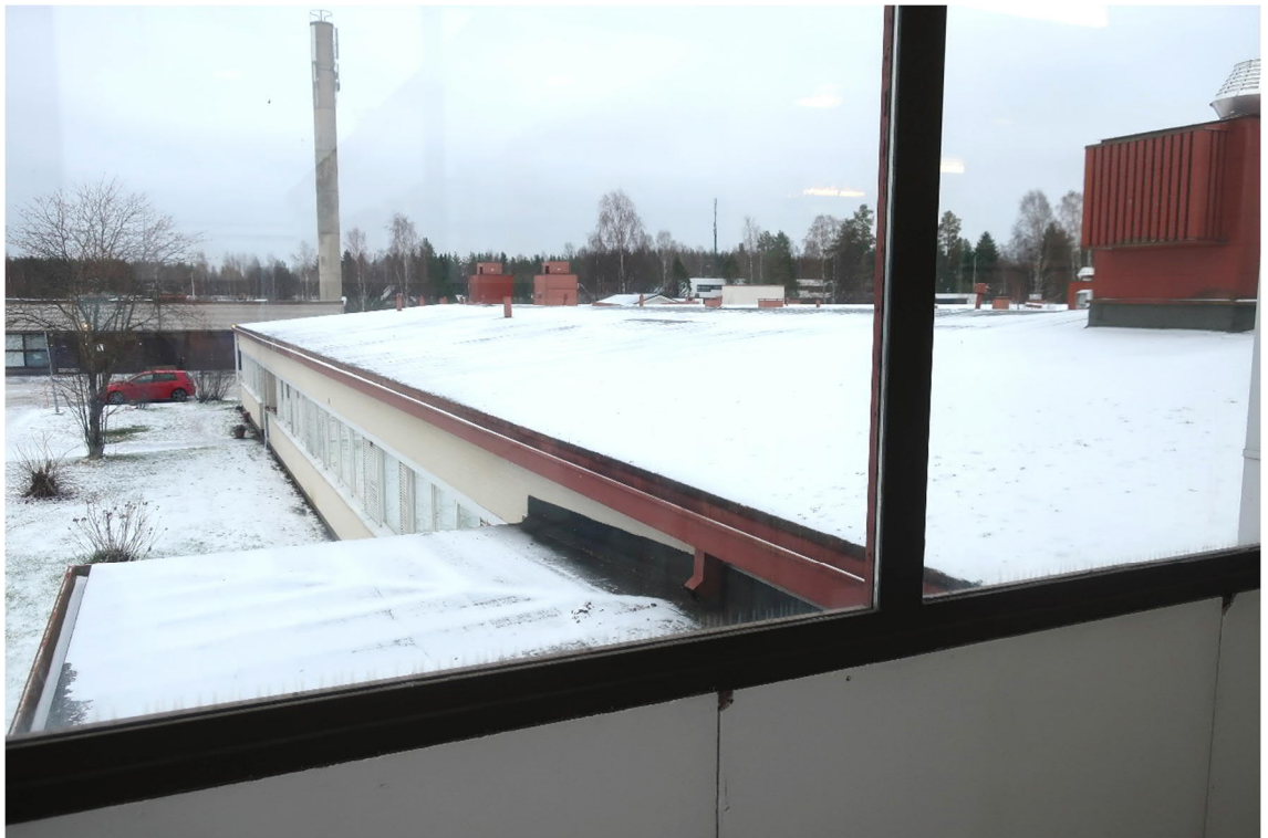
Kuva 60. Osan 1 pohjoissivun vesikatto kuvattuna porrashuoneesta 193c.
