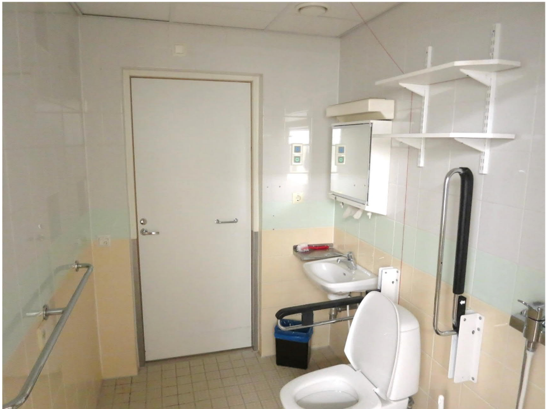
Kuva 66. 1. kerroksen wc-tiloissa/kylpyhuoneissa on lattia- ja seinäpinnoilla keraaminen laatoitus vuodelta 1994.
