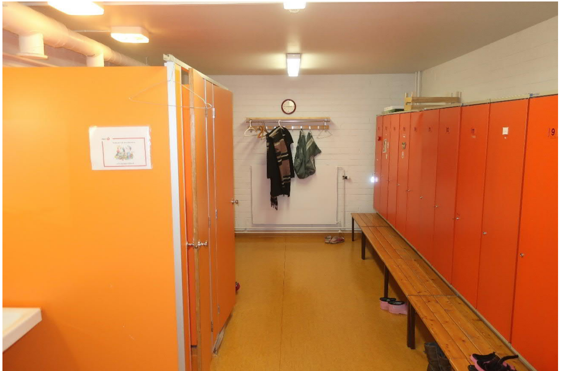
Kuva 64. Kellarikerroksessa märkätilojen lattianpäällysteenä on eri-ikäisiä muovimattoja.
