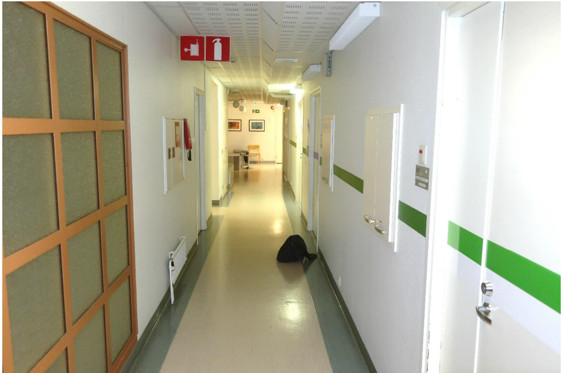
Kuva 37. Yleiskuva osan 3 2. kerroksen käytävältä, jonka muovimatto on vuodelta 1988 tai 1994.
