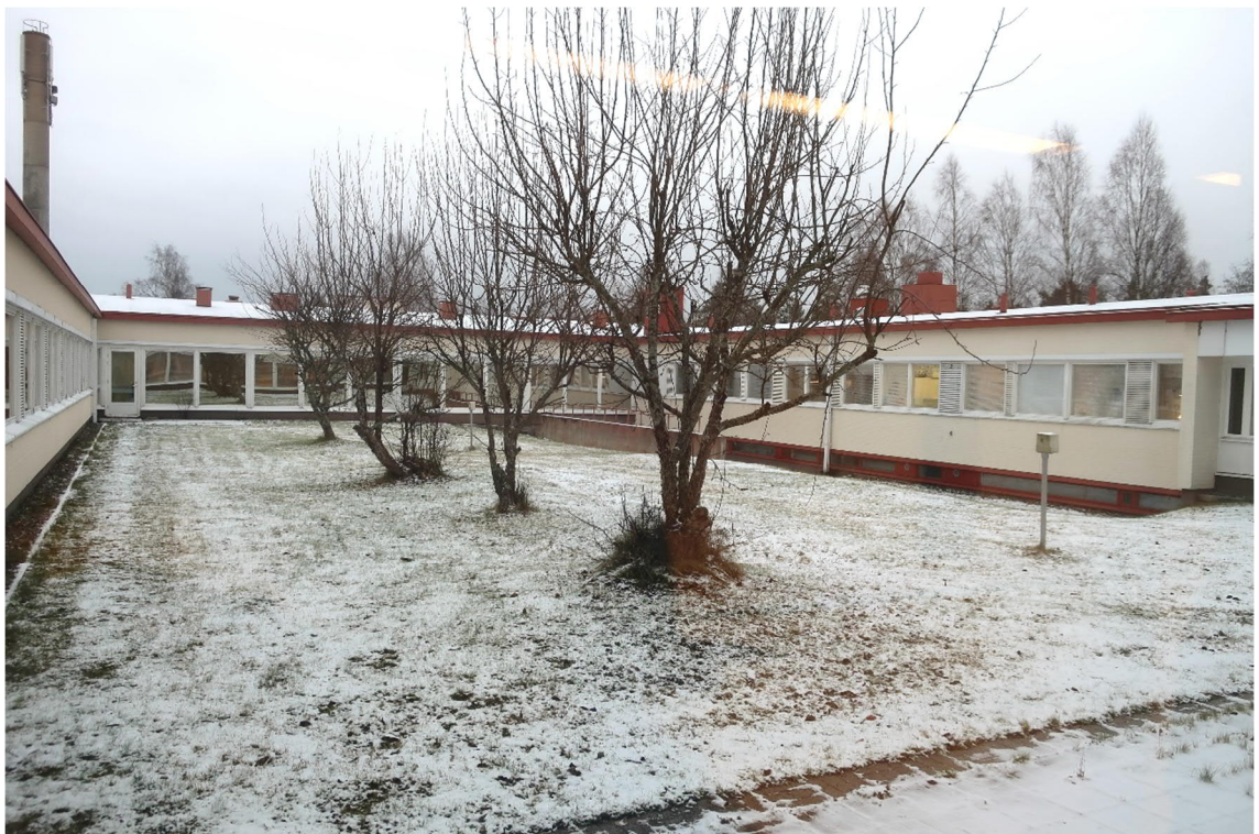
Kuva 2. Yleiskuva rakennuksen osien 1, 2 ja 3 väliin jäävältä sisäpihalta.
