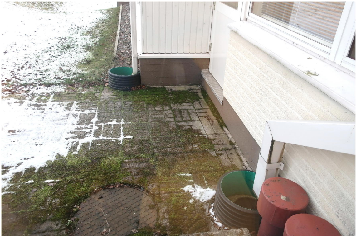
Kuva 44. Korkeampaa valesokkelirakennetta osan 3 sisäpihan puoleisen ulkoseinän alaosassa.
