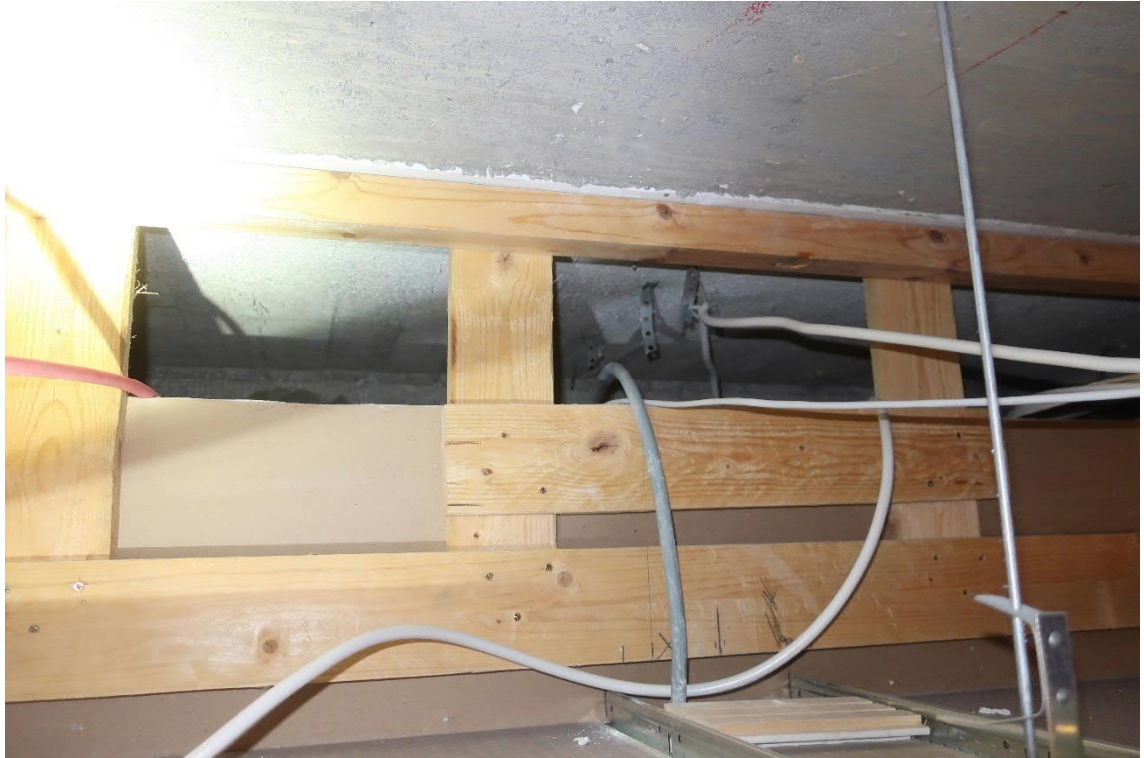
Kuva 63. Osan 1 yläpohjassa aiemmin olleiden kattoikkunoiden aukot on ummistettu betonivalulla siten, että ne ovat ilmatiiviit. Kuvassa lautamuottipintainen betonipinta on alkuperäistä yläpohjan betonivalua ja sileä betonipinta on ummistetun kattoikkunan aukon kohdalla. Kuva on otettu osan 1 1. kerroksen käytävän alakattotilasta.
