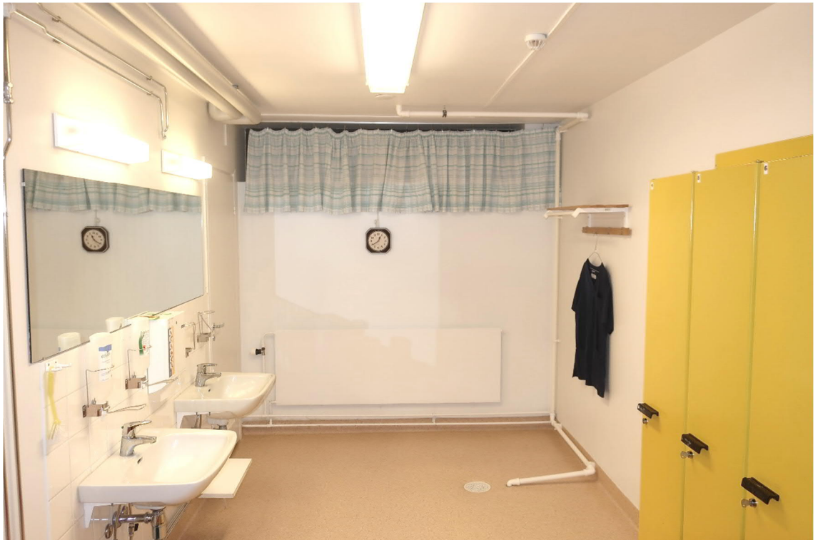
Kuva 65. Uusimmat kellarikerroksen märkätilojen lattianpäällysteet ovat vuosina 2006–2007 asennettuja muovimattoja.
