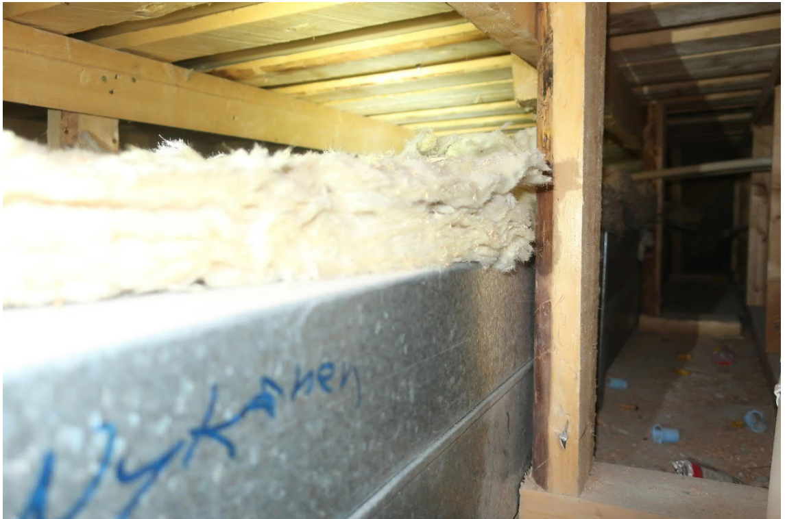
Kuva 34. Osan 3 välipohjassa (2. kerroksen lattia) on vuonna 1988 vanhan kantavan betonirakenteisen yläpohjan ja entisten puisten vesikattorakenteiden päälle tehty levyrakenteinen lattia. Puukoolatun levyrakenteisen lattian korkeus on noin 800 mm, ja se on alipaineistettu koneellisesti.
